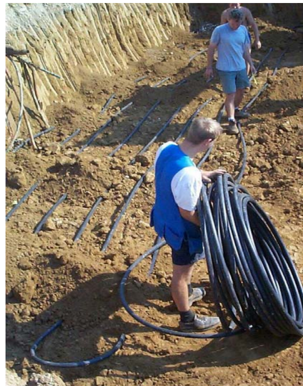
Прокладка земляного коллектора
