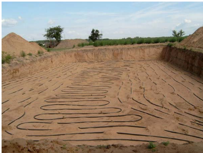
Земляной коллектор перед засыпкой песком
