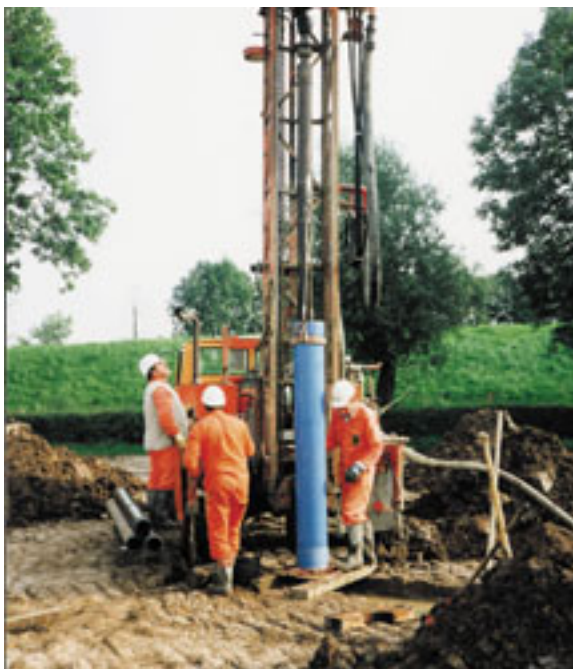
Бурение системы скважин
