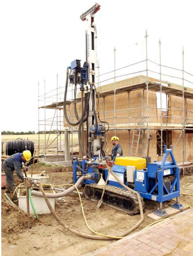
Бурение скважины земляного зонда при помощи гусеничной машины
