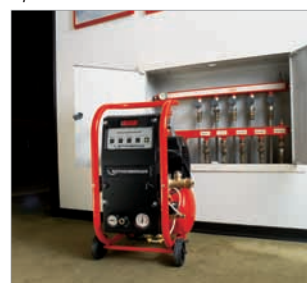
Промывка системы отопления пола
