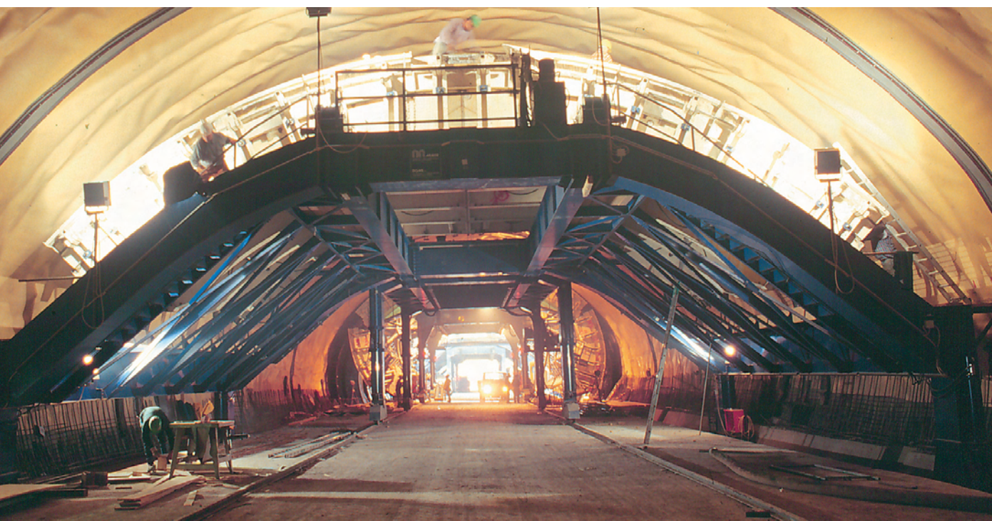
Площадка по строительству туннеля фирмы Цюблин
