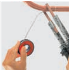
Нагрев места пайки без использования пламени
