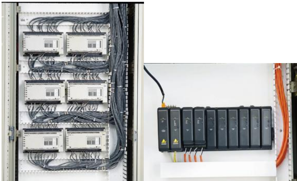
Рис. 4 Проводка для традиционной технологии в/в по сравнению с DeltaV Fieldbus
